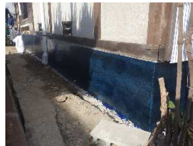
写真-3 基礎炭素繊維補強
