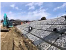
写真-7 護岸工事
