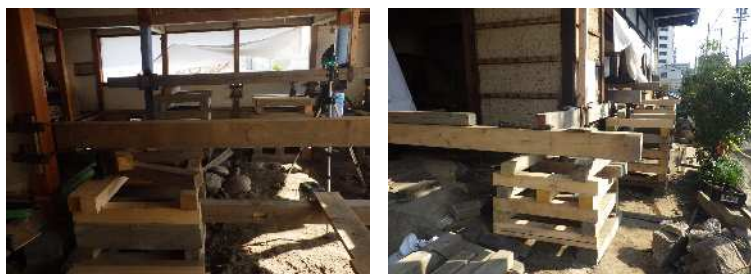
写真-4,5 ジャッキアップ状況
