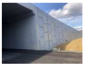
写真-8 補強土壁工事
