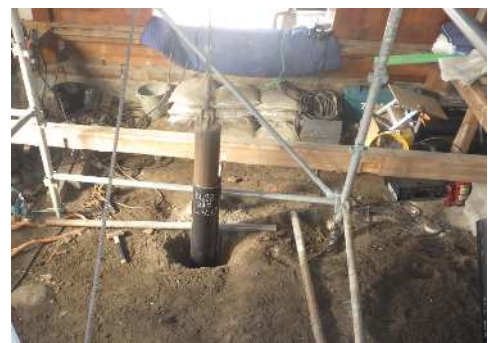
写真-2 モンケン打設状況
