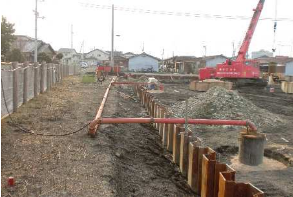
写真-5 ディープウエル設置状況
