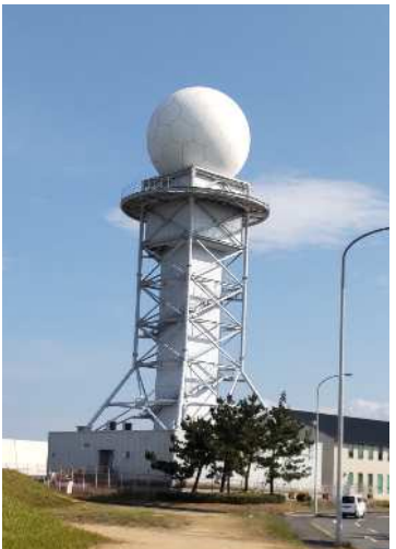
写真-1 ドップラーレーダー
