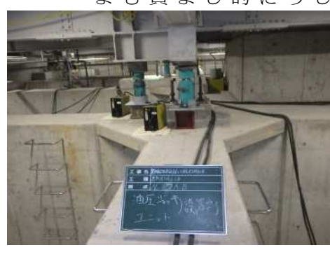
写真-2 ジャッキ設置状況
