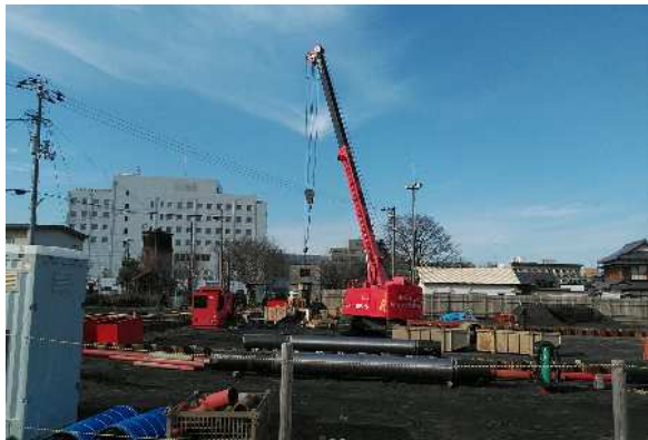
写真-4 施工状況
