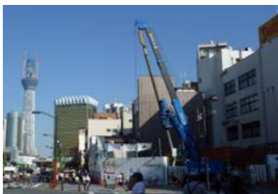
写真-5 杭打工事状況
