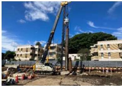
写真-4 杭撤去状況
