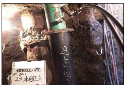
写真-2 鋼管杭圧入状況
