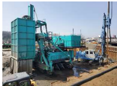
写真-5 TRD機と深層混合攪拌機
