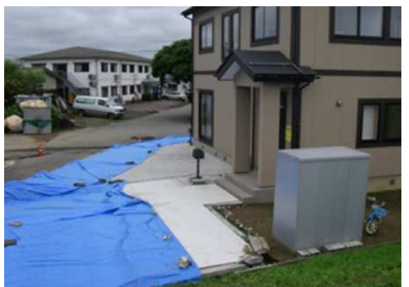
写真-1 中越沖地震による新築住宅の液状化被害
