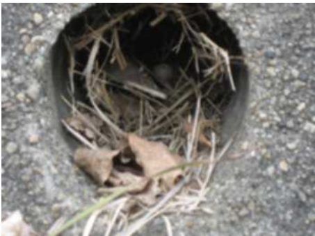
写真1 鳥の卵が有る水抜き穴
