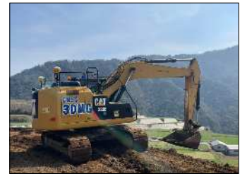
写真-14 GNSS搭載重機
