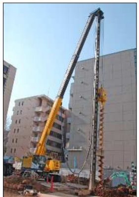
写真-17 管理装置取付 施工機械一例
